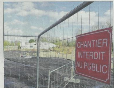
Une fois que la nouvelle piscine sera terminée, il faudra démonter l'actuelle : l'opération est estimée à 70 000 €.
